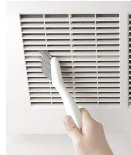
エアコンの吹き出し口にも
